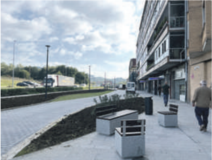
Bidebarrieta kalea oinezkoentzat egokitu dute.
