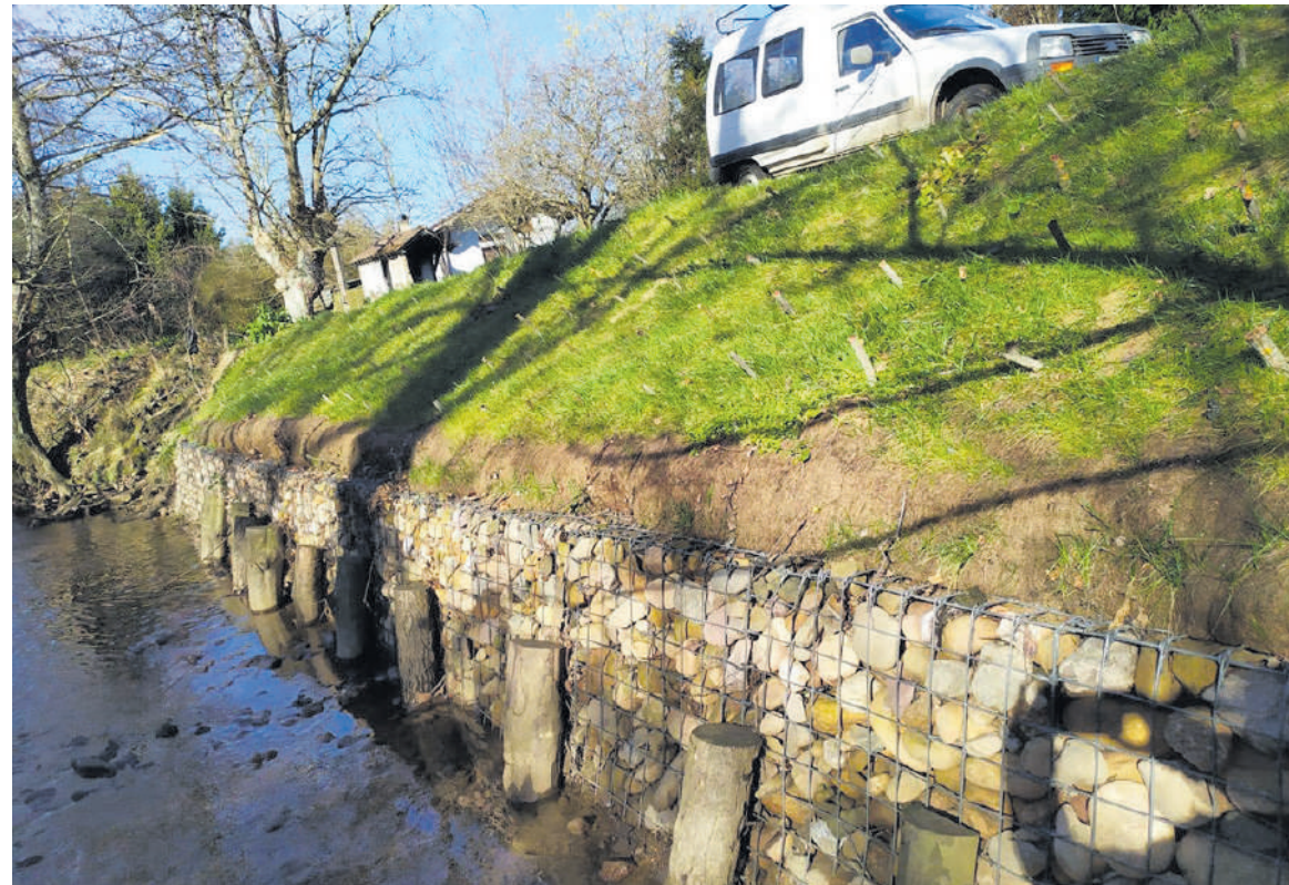
Lanak egin dituzten tokia: errekarren ondoan errekarri egindako horma, eta bere gainaldean lurra, sahats adarrekin.
