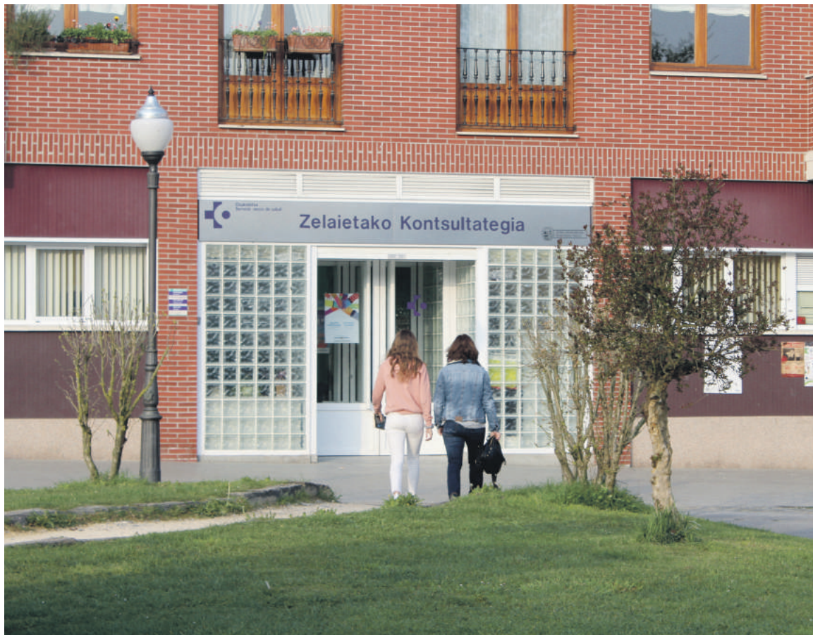
Abadiñoko Osasun Zentroa.
