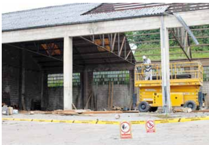
Belakortu zerrategian amiantoa kentzen ibili dira, astean, langileak.
