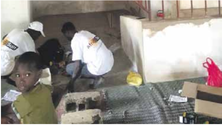
Fokuak instalatzen ibili dira azkenaldian.
