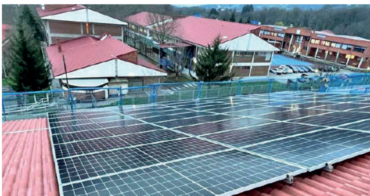
54 eguzki panel instalatu dituzte ikastetxeko teilatuan.
