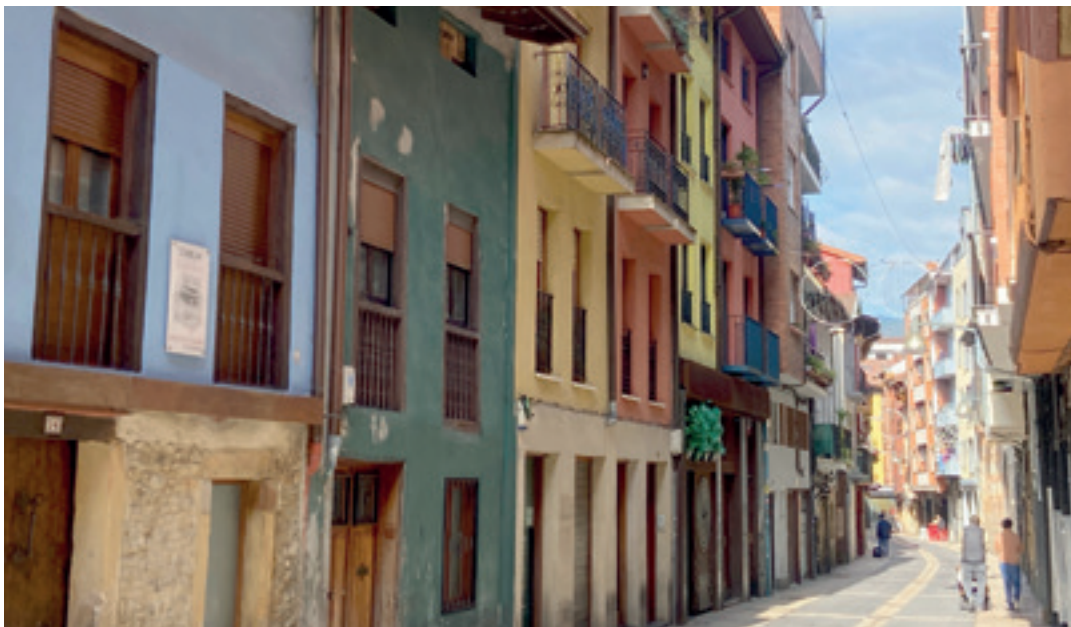
Etxebizitzak Durangoko Alde Zaharrean.
