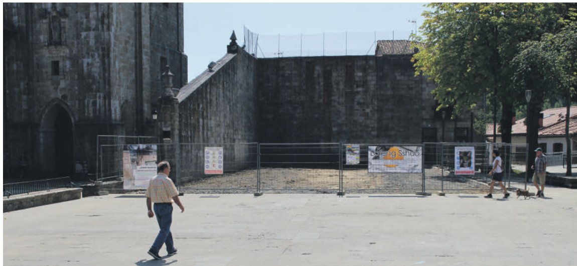
Batez ere, pilotalekuko zorua eta hormak konponduko dituzte.
