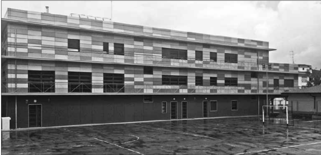
Ikastetxeak hiru solairu ditu; lehenengoan ikasgelak daude eta bigarrenean erabilera anitzeko gelak.
