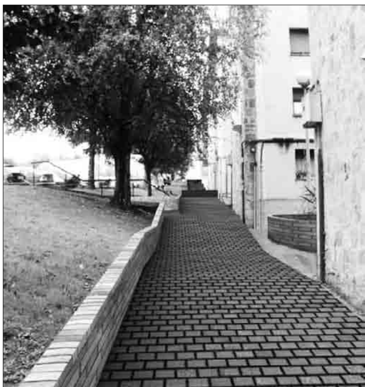
Kurutziaga-Astarloa lotunean ere asfalto inprimatua ipini dute.
