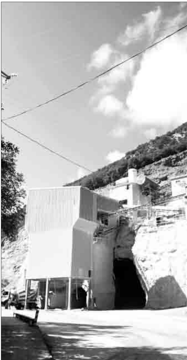
Urkuleta auzoko 'Canteras y Hormigones Zalloventa'. Iban Gorriti
