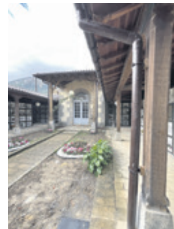
Hilerria kanalizazio berriagaz.
